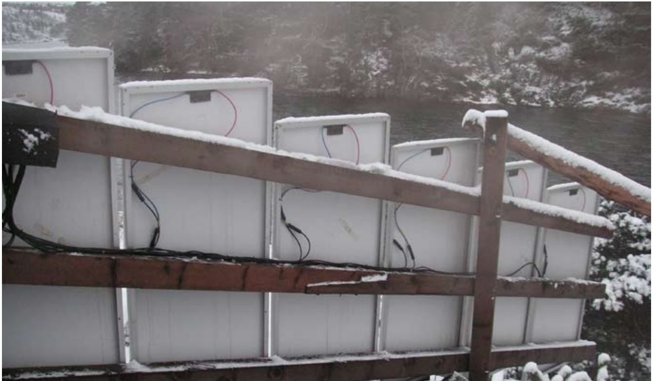
Trevirke for festing av solcellepaneler
