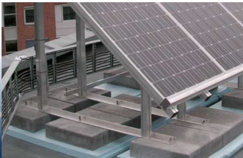
← Stativ i aluminium, en enkel løsning for solcelleanlegg på flatt tak.
