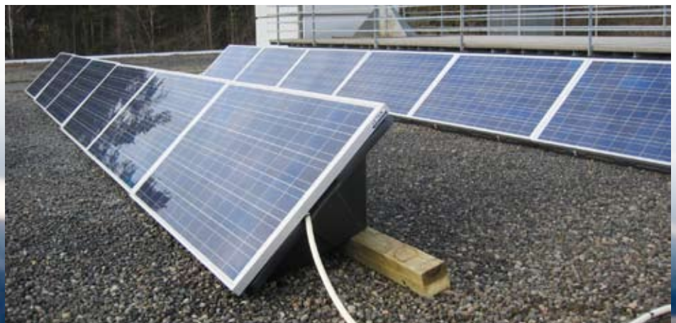
← Plastkonstruksjon fylt med sand er en praktisk og enkel løsning for montasje av solcellepaneler.
