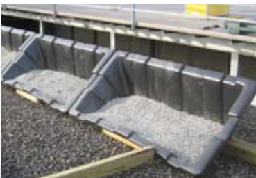
← Plastkonstruksjon fylt med sand er en praktisk og enkel løsning for montasje av solcellepaneler.
