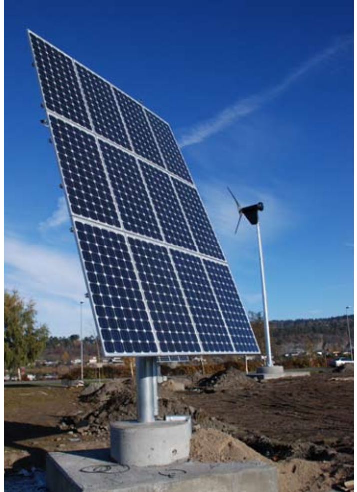
← Frittsående konstruksjon med muligheter for å justere panelets vinkel og retning. En optimal løsning for den profesjonelle kunde. 2-aksial SunTracker gir >30° mereffekt.
