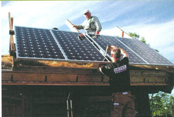
Montasje av solcelleelementer, som er en viktig komponent i GETEKs energileveranser.
