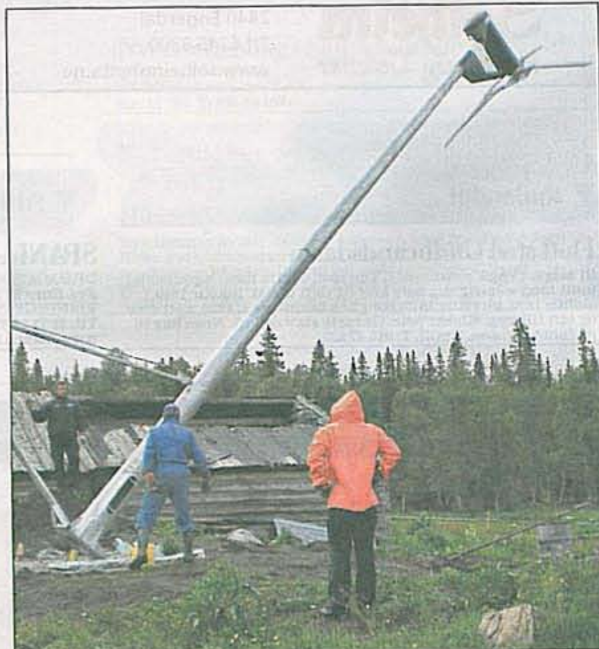
Vindgenerator skal monteres så høyt og fritt som mulig. Det fins vertikalakslede modeller for steder hvor det kan være ekstra tøffe forhold.
